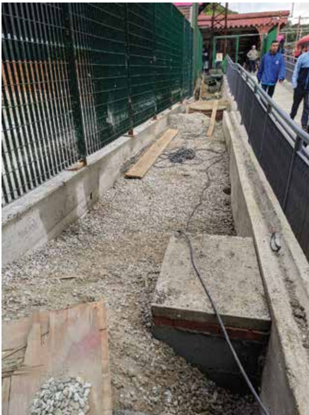
Figuras 9 y 10: Macetero con lecho de gravas y plantando las especies en octubre del 2019
